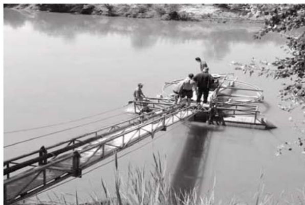
Fig. 3. Prototipul industrial al microhidrocentralei de conversie a energiei cinetice a apei (a) instalat pe r. Prut, c. Stoieniști, Cantemir (b).
