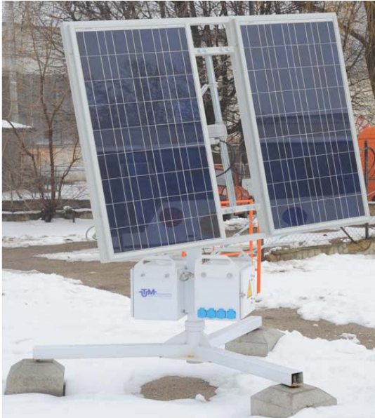
Fig. 5. Instalație fotovoltaică cu orientare automată la soare pentru alimentarea cu energie electrică a posturilor antigrindină și pomparea apei
