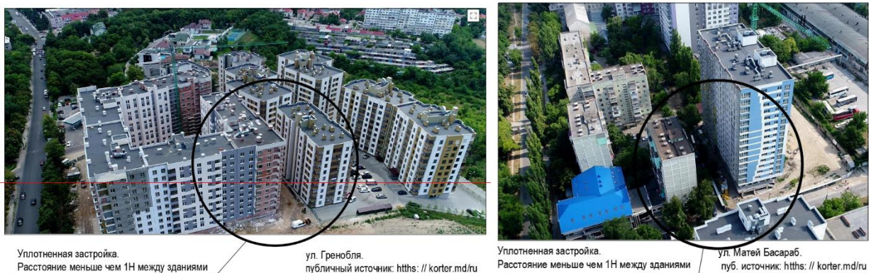
Рисунок 1. Уплотнение застройки в г. Кишиневе
