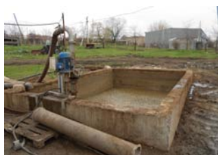
Figura 2. Rezervorul de stocare a materiei prime
