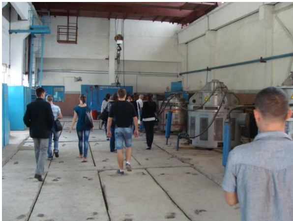
Fig. 1.1. Stația principală de pompare
