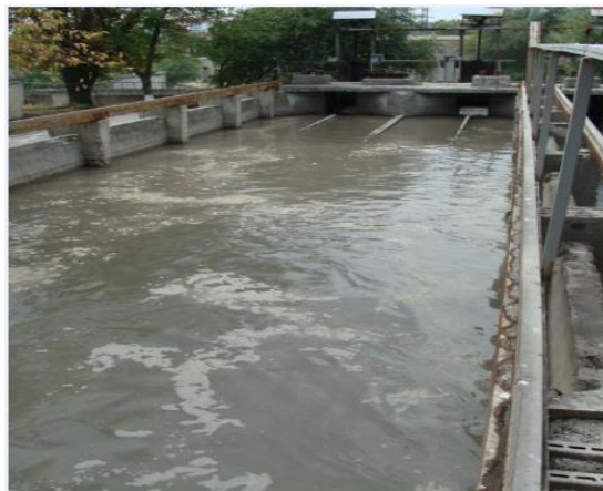
Fig. 1.2. Deznisipator orizontal longitudinal
