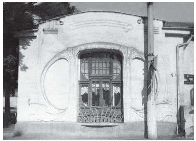
Fig. 10. Poșta Orășenească (fost imobil rezidențial) din strada Ștefan cel Mare, Bălți
