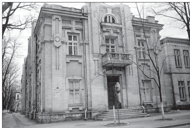
Fig. 1. Clădirea fostei Comunități a Surorilor Medicale „Crucea Roșie” a Mănăstirii Hârbovăț, str. Vlaicu Pârcălab nr. 46.
