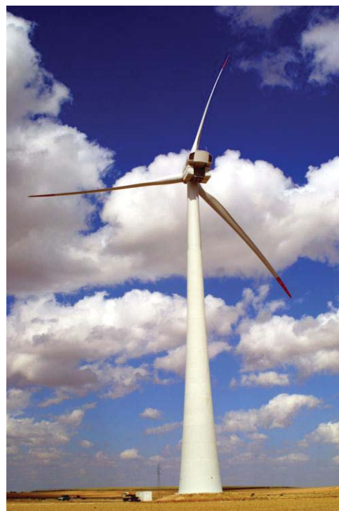
Fig.2. Turbină eoliană Vestas de 2 MW produsă în anii 1999-2004.
