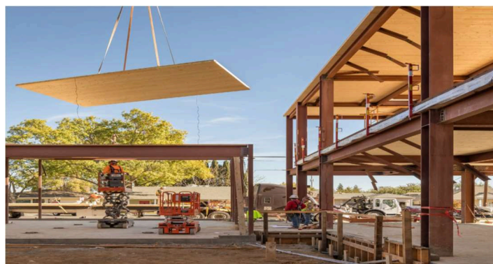
Figura 5. Reprezentarea montării panourilor Mass Timber Denumirea proiectului: Brentwood Public Library Locația: Brentwood, CA [2]
