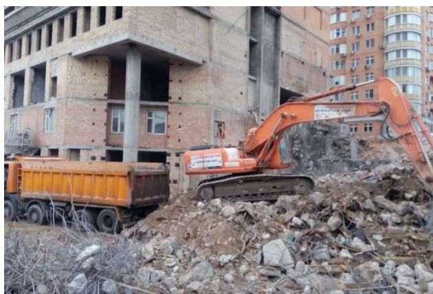
Fig. 1. Demolarea unei construcții din beton armat [3]
