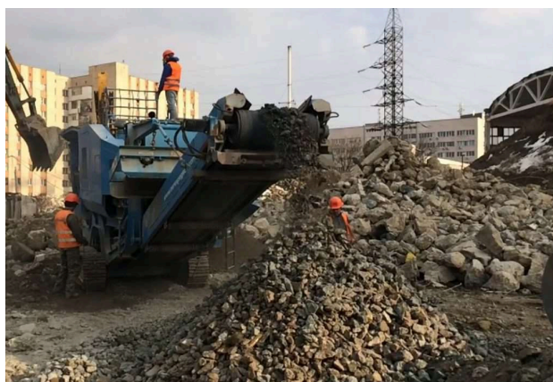
Fig. 2. Concasarea betonului [4]
