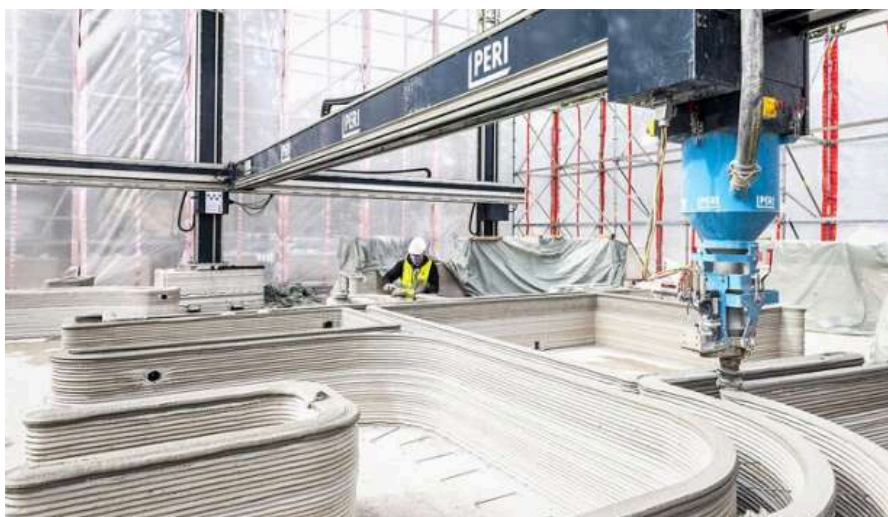
Fig. 2. Tehnologia de printare
