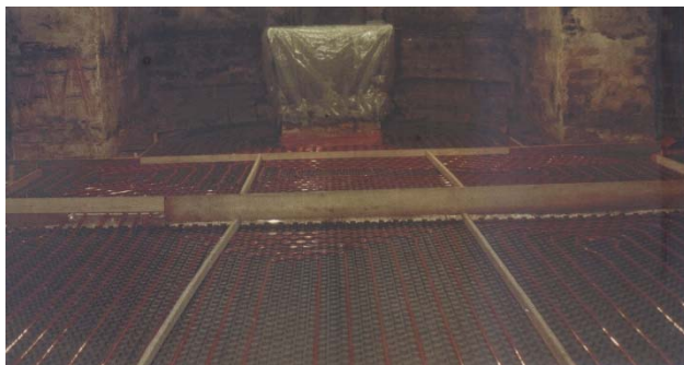
Fig. 2. Sisteme de încălzire în pardoseală [19].
