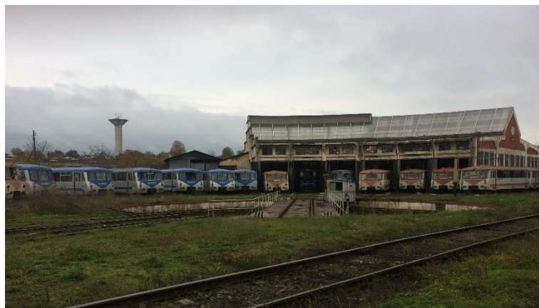
Fig. 2. Hală reparații cu placă rotativă pentru mentenanță automotoare mici.
