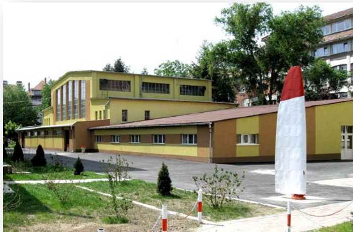
Fig. 4. Laboratorul de Mașini Hidraulice din Timișoara, operă a prof. Aurel Bărglăzan, reechipat și extins recent pentru didactic și cercetare (fotografia din spate).
