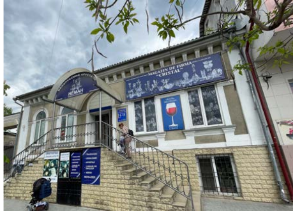
Str. Alexandru cel Bun, 36. Monument de arhitectură de importanță locală, edificat la mijlocul sec. XIX.
