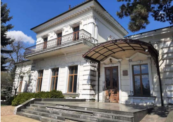
str. Alexei Mateevici, 72. Monument de arhitectură de importanță națională, construit în perioada anilor 1902–1903.
