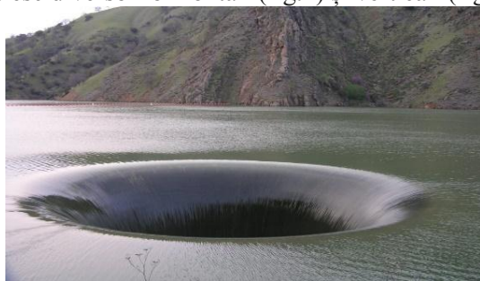
Figura 3: Diversor vertical
