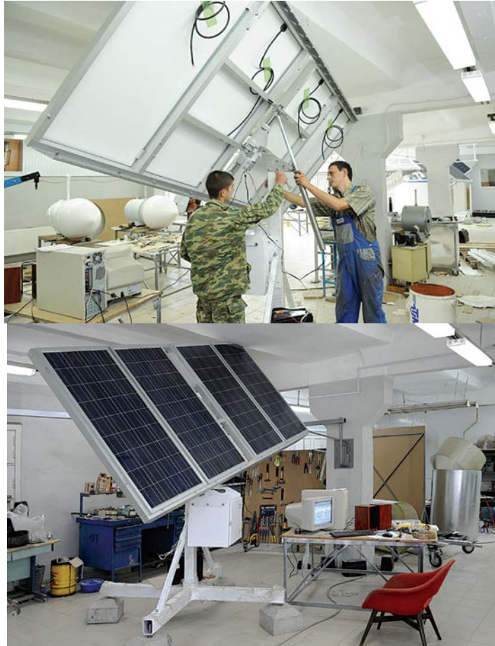
Fig. 29. Asamblarea sistemelor de conversie a energiei solare cu orientare astronomică, CITA Etalon, UTM.
