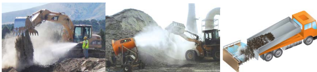
Fig. 8. Metode de reducere a prafului la diferite activități pe șantier [14, 15]
