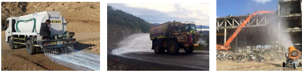
Fig. 2 Utilaje pentru stropit pe șantier [5, 6, 9]
