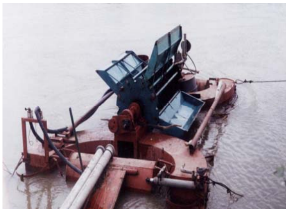
Fig. 9. Instalație plutitoare hidroenergetică pe r.Prut (Stoianești, r.Cantemir) pentru pomparea apei în lac.
