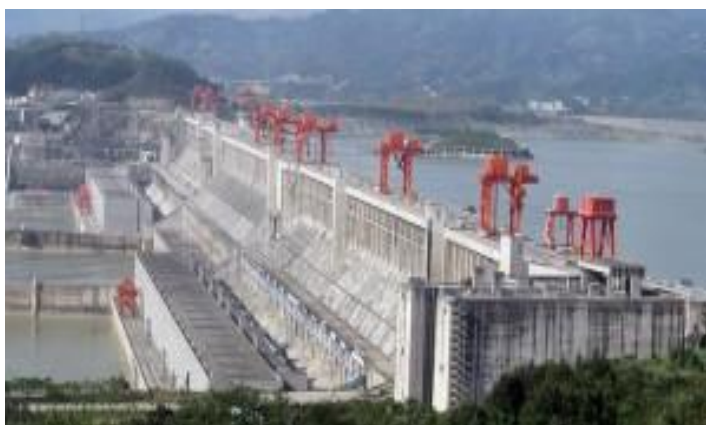
Figura 2. Cea mai mare hidrocentrală din lume are o capacitate instalată de 22.500 MW și poate asigura, dacă funcționează la maximum de exemplu, de două ori și jumătate întregul consum de electricitate al României. Hidrocentrala ChinaFoto: dailymail
