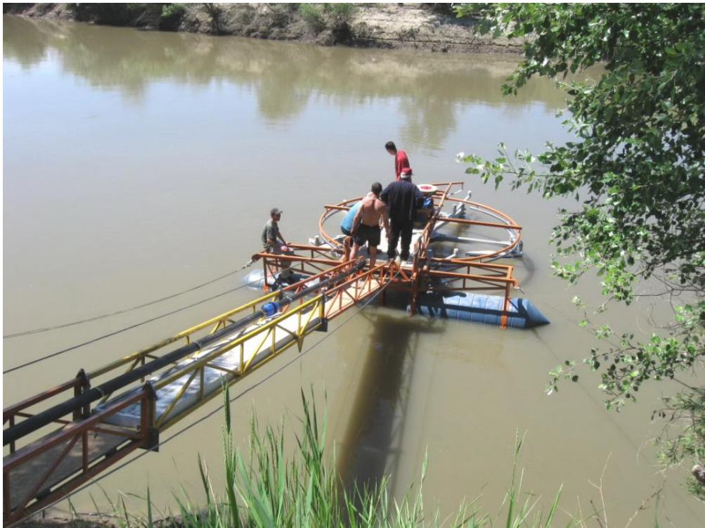
Fig. 6.29. Prototipul industrial al microhidrocentralei cu pale hidrodinamice cu lungimea cordului c = 1300 mm, instalată pe poligonul de încercări de pe r. Prut, com. Stoienești, Cantemir.
