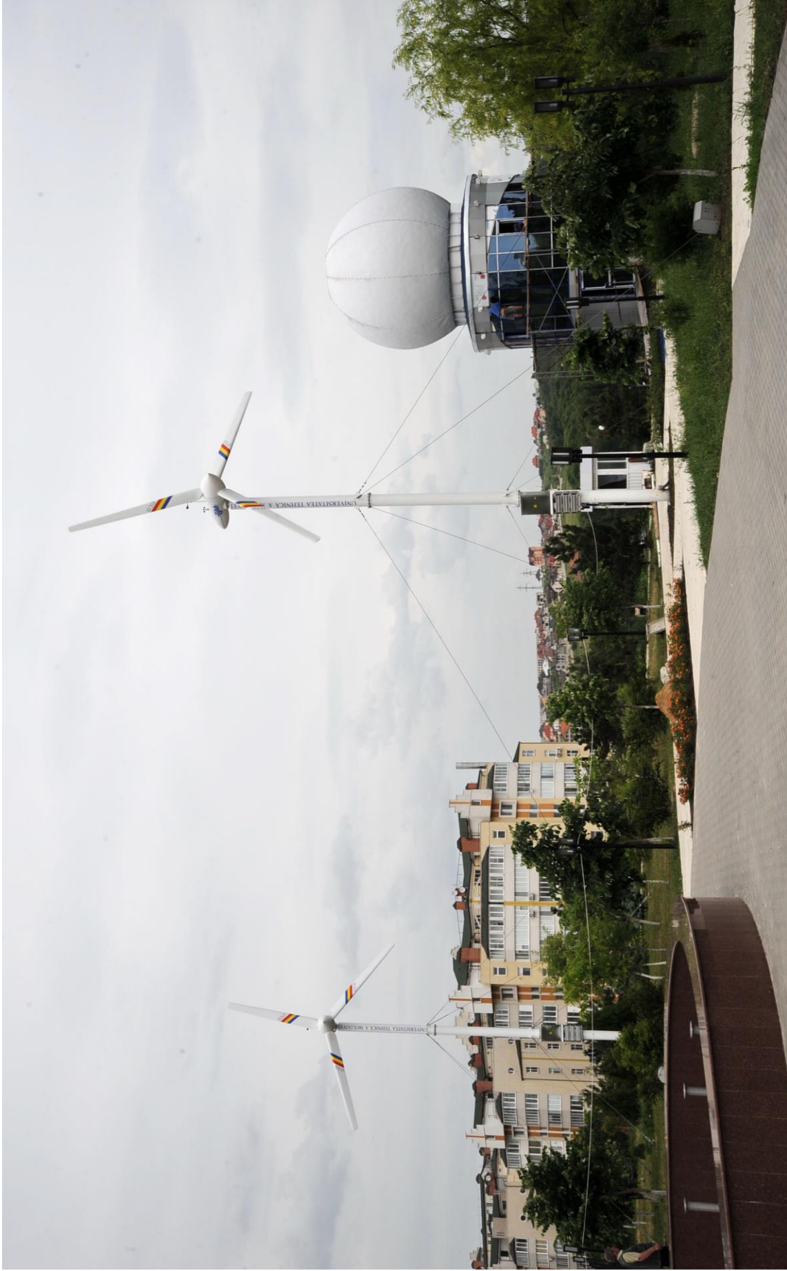
Fig. D.5. Vederea generală a turbinelor eoliene cu puterea de 10 kW fiecare, cu orientarea la direcția curenților de aer prin windrose și electronic, destinate pentru iluminarea Parcului-Muzeu al Tehnicii, campusul Râșcani, UTM.
