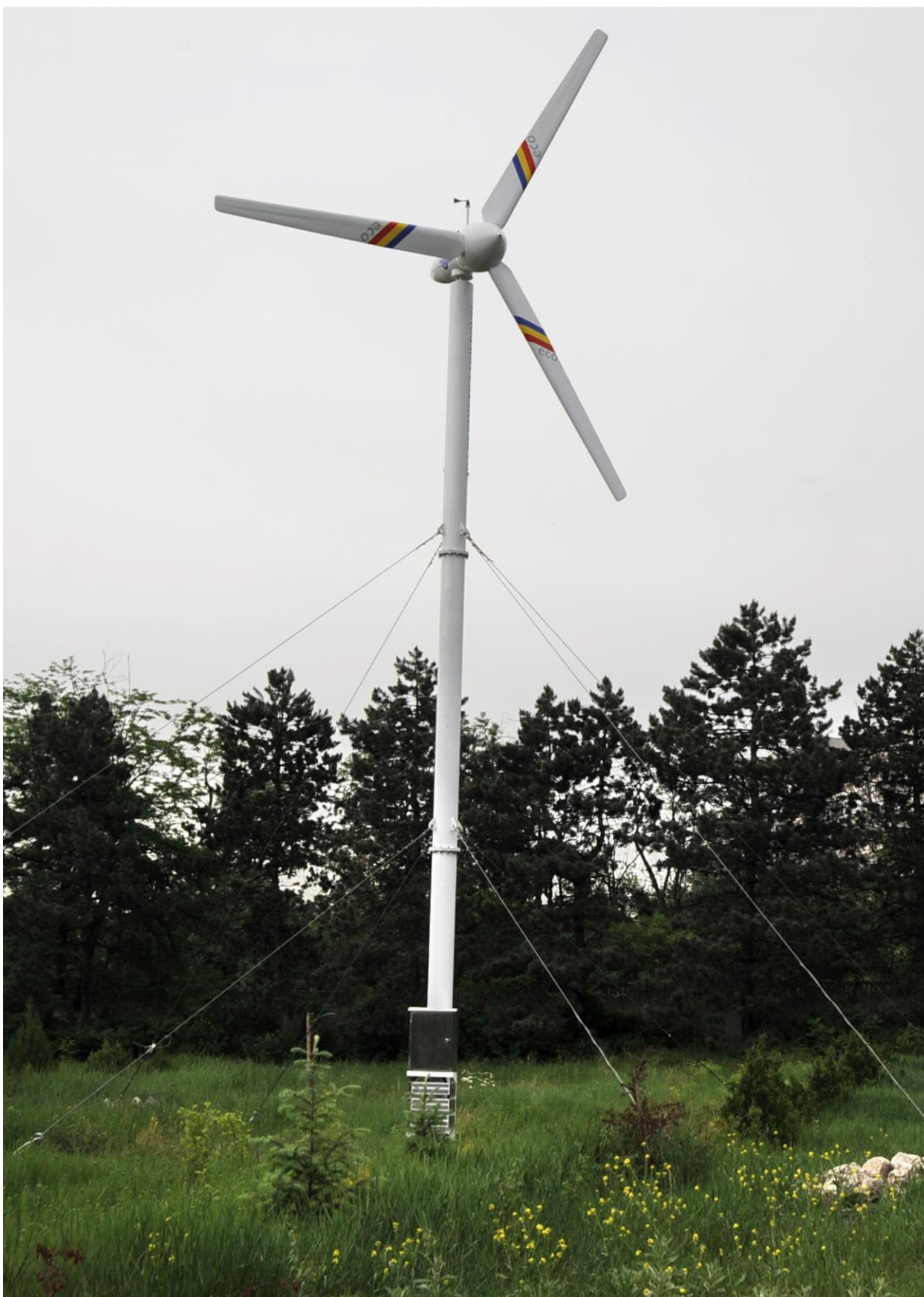
Fig. D.7. Vederea generală a turbinei eoliene cu puterea de 10 kW destinată pentru încălzirea serelor și iluminare instalată în anul 2013 în Grădina Botanică (Institut) a AȘM.
