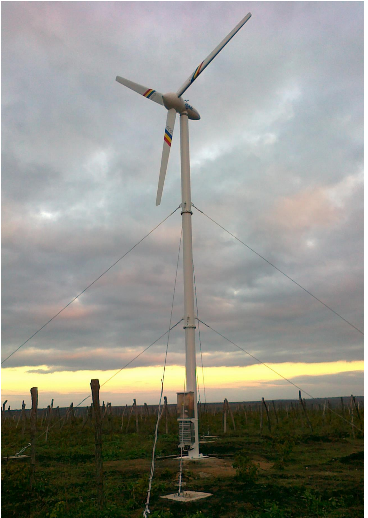
Fig. D.8. Vederea generală a turbinei eoliene cu puterea de 10 kW destinată pentru încălzirea rezidențială și iluminare instalată în anul 2013 în comuna Țințăreni.
