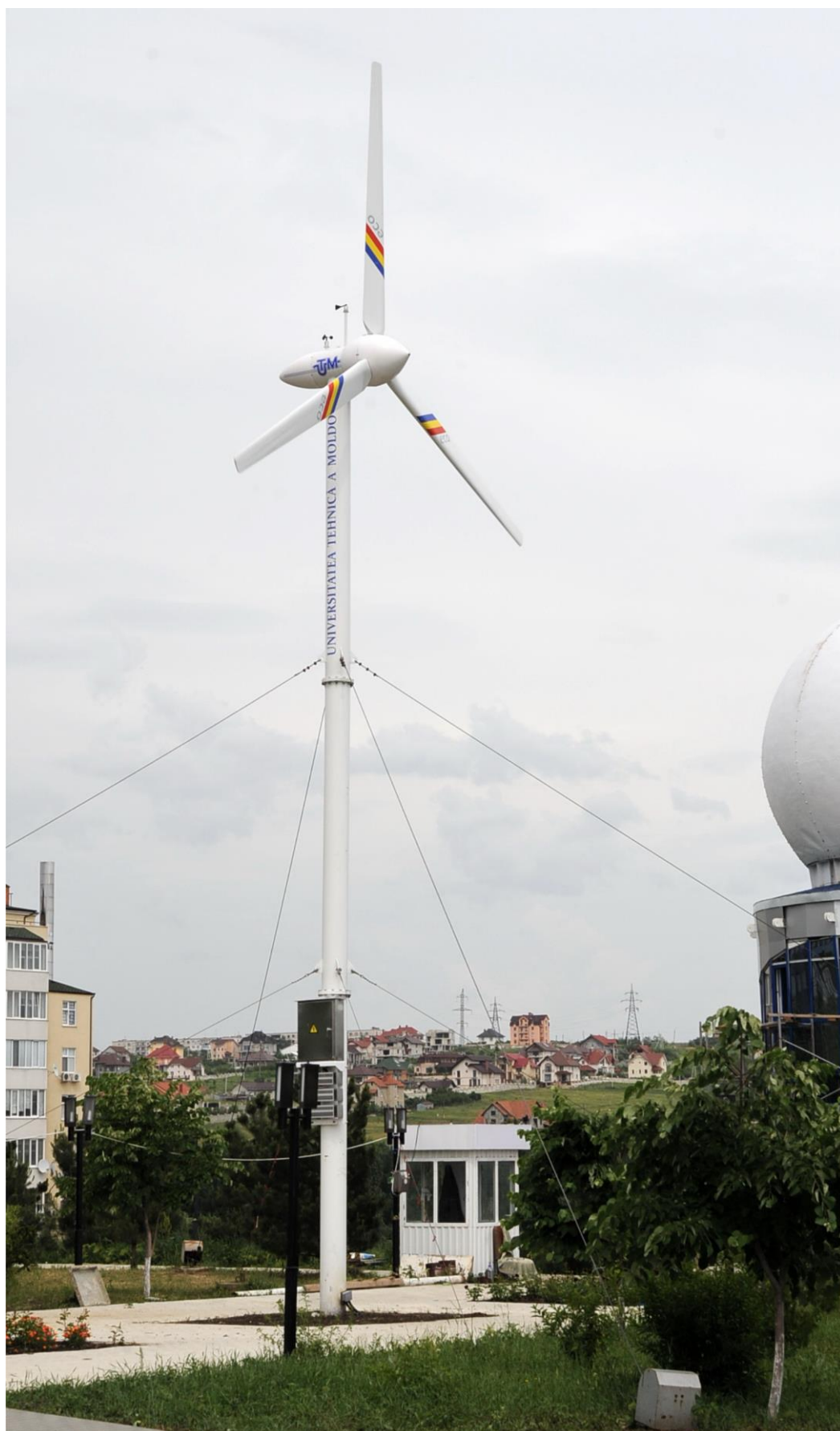
Fig. D.9. Vederea generală a turbinei eoliene cu puterea de 10 kW cu profil aerodinamic I al palelor instalată în anul 2012 în Parcul-Muzeu al Tehnicii, campusul Râșcani, UTM.
