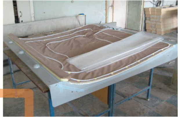
b) Instalarea în formă a membranei și accesoriilor de vidare.
