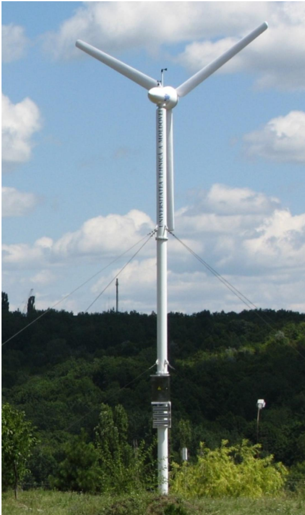
Fig. D.10. Vederea generală a turbinei eoliene cu puterea de 10 kW cu profil aerodinamic I al palelor instalată în anul 2010 în Parcul-Muzeu al Tehnicii, campusul Râșcani, UTM.
