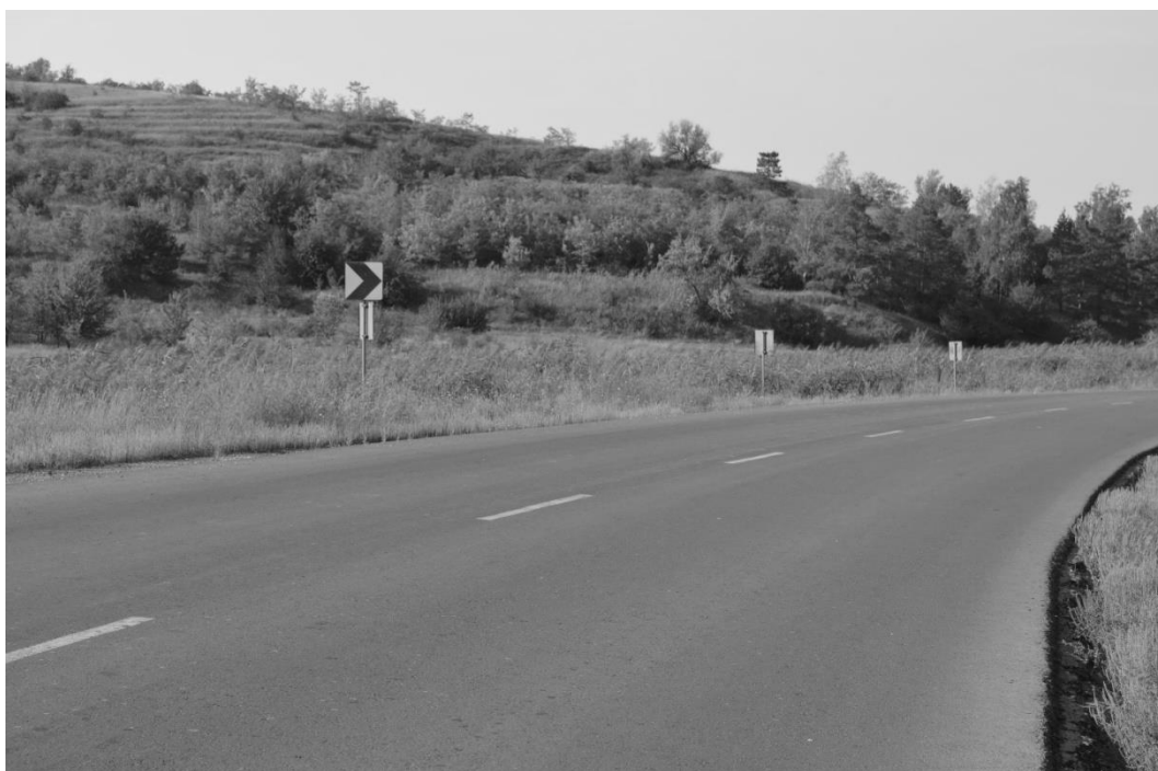
Рис. 2. Оползневые деформации на склоне, вызванные его подрезкой при строительстве автодороги Кишинэу-Унгень.
