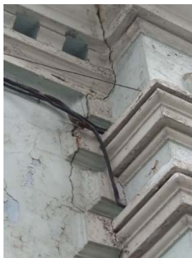
Fig.3.17. Fisurarea pereților clădirilor monumente arhitecturale
