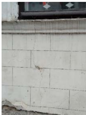
Fig.3.17. Fisurarea pereților clădirilor monumente arhitecturale
