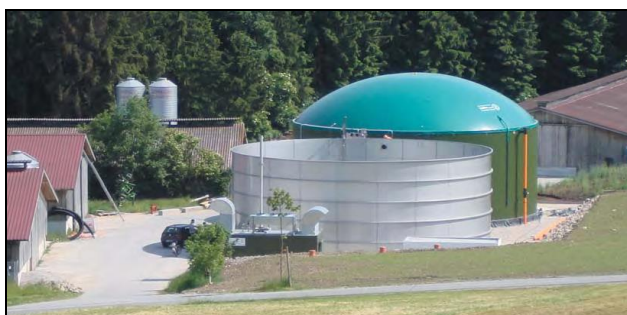
Figura 2. Vederea de ansamblu a unei stații de producere a biogazului, (Firma germană „Luthe GmbH Biogasanlagen”)
