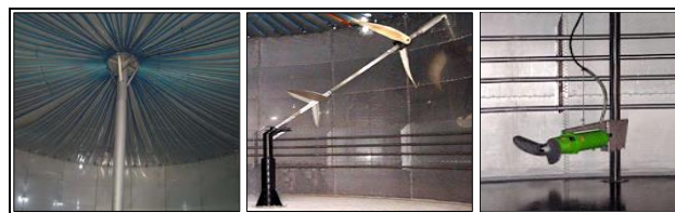
Figura 4. Interiorul fermentatorului și amestecătoarele folosite
