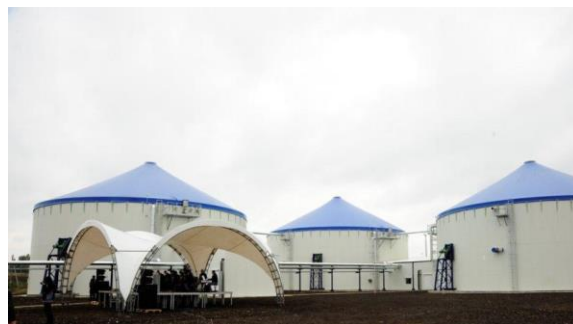
Figura A2.5. Vedere a fabricii de biogaz
