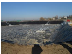
Figura A2.8. Laguna de stocare digestat, Drochia
