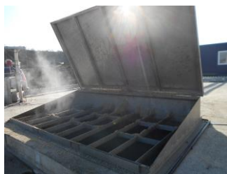
Figura A2.6. Rezervor de stocare a substratului
