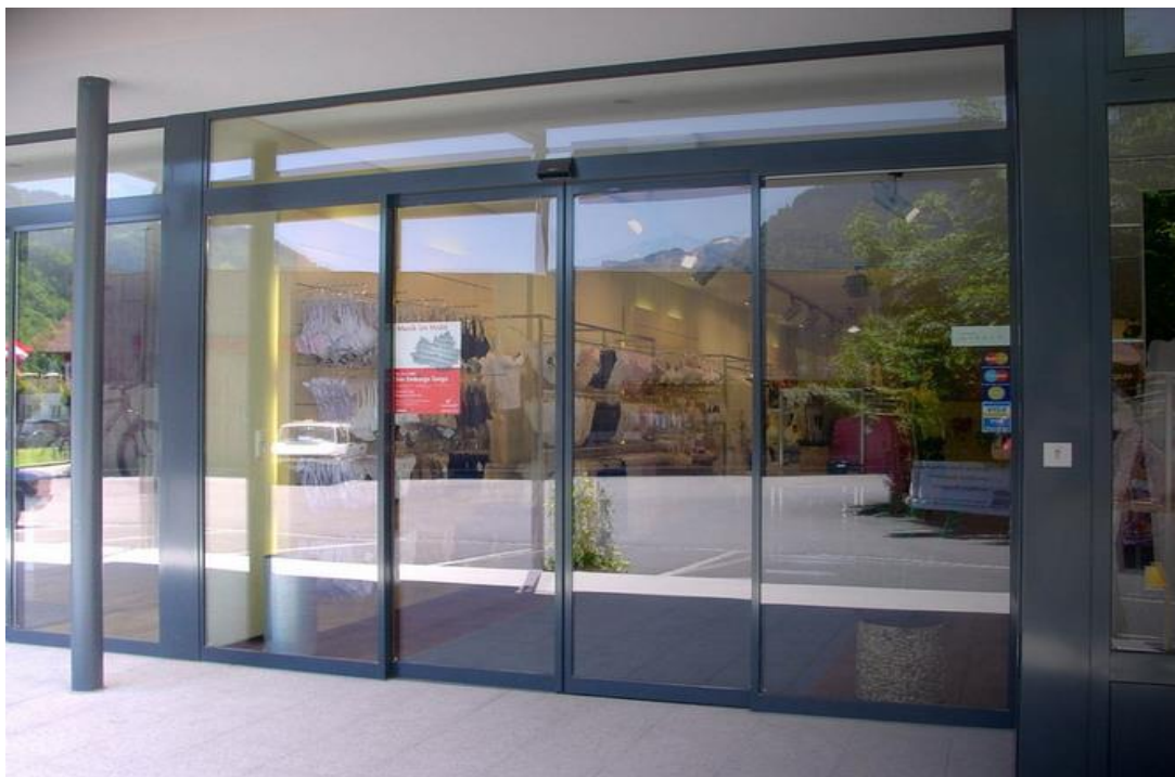
Figura 3. Automatizarea ușilor efectuată de către releul inteligent Zelio Logic
