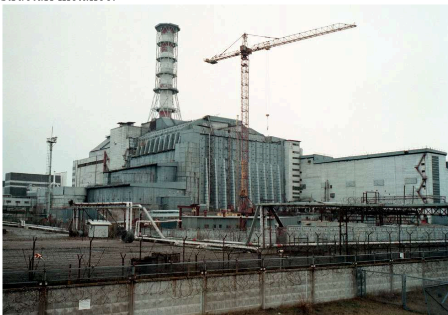
Fig. 3 Primul sarcofag din beton al reactorului de la Cernobîl [3]
