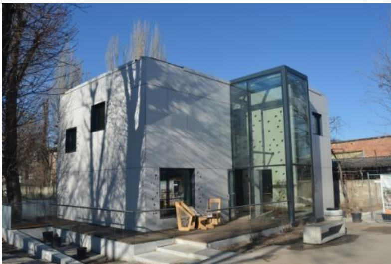
Figura 4.12: Fațada sud a clădirii pasive solare EFdeN, F.I.I., București
