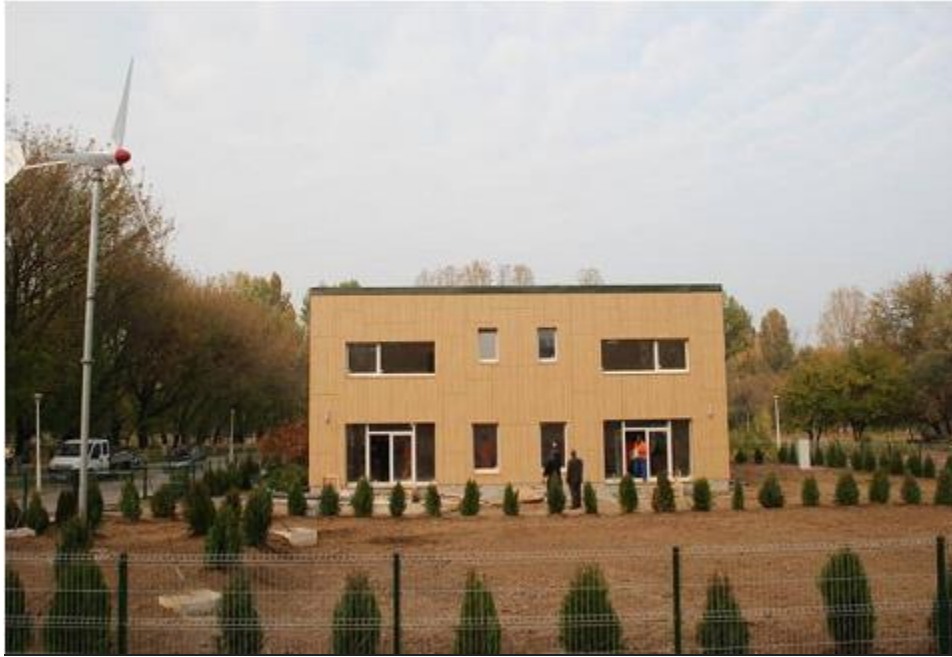
Figura 1.10: Fațada sud a clădirii pasive din campusul Universității "Politehnica" din București.
