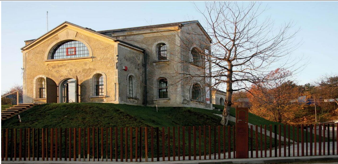
Figura 5. Centrul de Arhitectură, Cultură Urbană și Peisaj “Uzina de Apa” Suceava.
