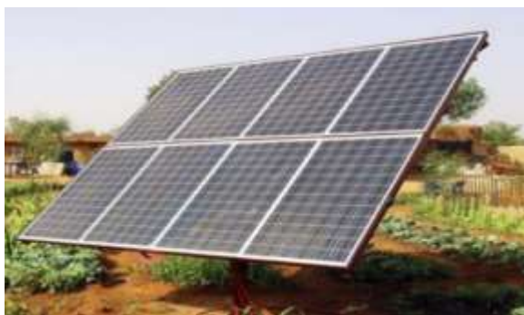
Fig. 4.12. Grup de panouri fotovoltaice monocristaline de tip LR4-60HIH(8*375W=3.0kW) [91]
