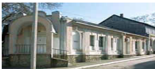
Imobil brutărie str. Cojocarilor 19
