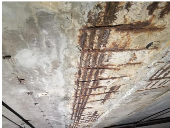
Figura 1. Coroziunea armăturii [2]
