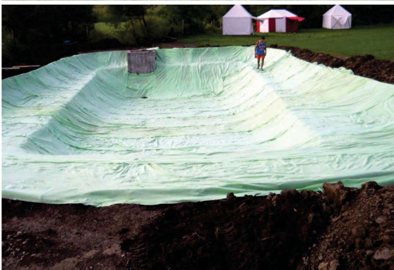
Fig. 3.11-3.12. Construcția unui iaz pluvial
