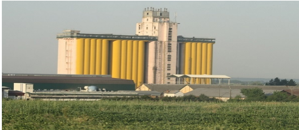
Fig. 3.29. Siloz de cereale cu celule din beton armat, în județul Timiș (proprietar Comcereal S.A).
