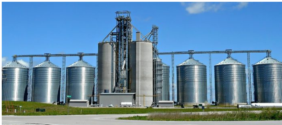
Fig. 3.30. Stație modernă de recepție , condiționare și depozitare produse agricole, întâlnită și la marii producători agricoli din România
