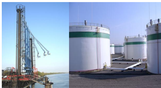
Figura 1. Terminalul și depozitul produselor petroliere din PILG
