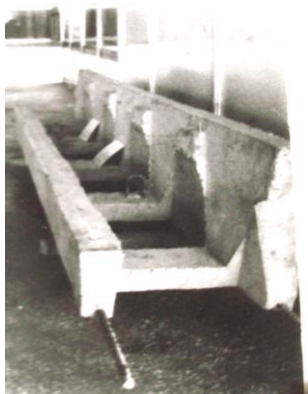
Рис. 2.7. Опытный образец сборного блока СбМт пояса ( Тип 1 ), представленный на выставку в Молдове, где разработки автора были удостоены второй премии [35].
