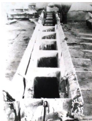
Рис. 2.7. Опытный образец сборного блока СбМт пояса ( Тип 1 ), представленный на выставку в Молдове, где разработки автора были удостоены второй премии [35].
