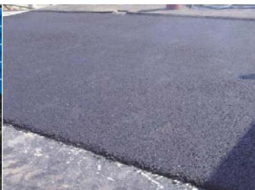
Figura 3 Stratul așternut prin tehnologia Novachip
