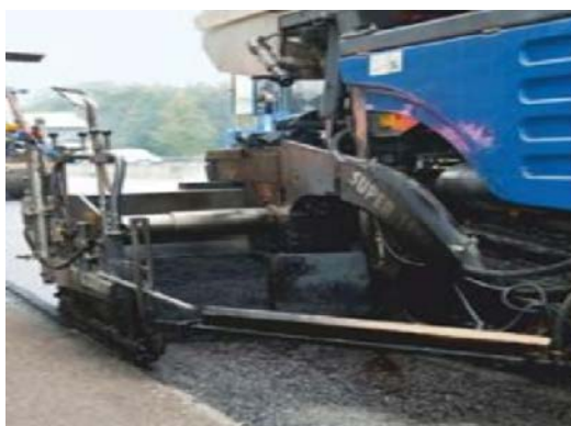
Figura 2. Așternerea mixturii bituminoase prin tehnologia Novachip
