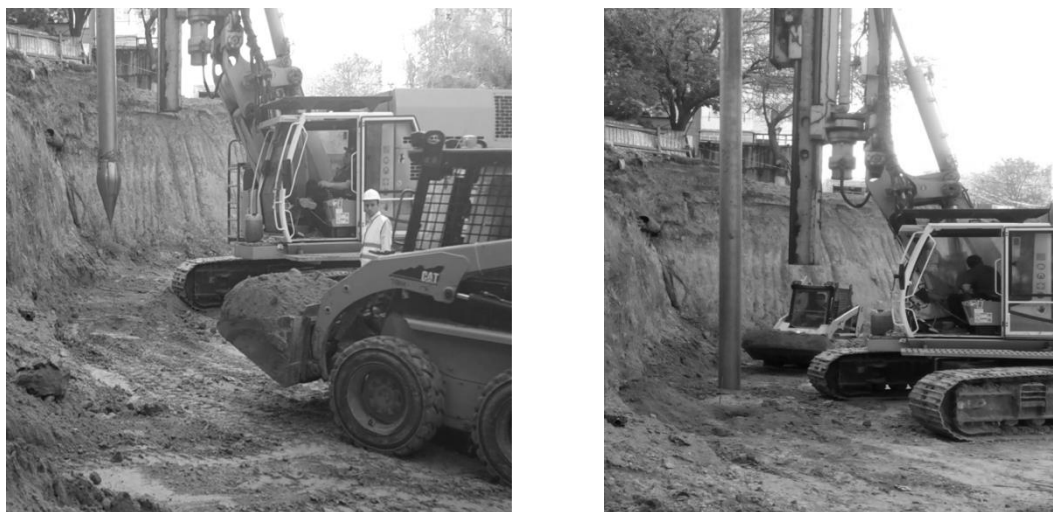
Рис. 1 Устройство грунтовых свай с помощью установки RG.
