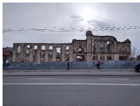
Figura 7. Clădirea fostei sinagogi cu azil pentru bătrâni, Chișinău, str. V. Alecsandri. Monument de arhitectură de valoare locală (2020).
