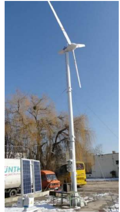
Figura 7.1 (b) Turbine eoliene fabricate la UTM cu orientare cu servomotor la direcția vântului, puterea nominală de 10kW
