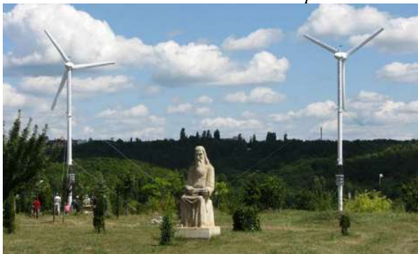
Figura 7.1 (b) Turbine eoliene fabricate la UTM cu orientare cu servomotor la direcția vântului, puterea nominală de 10kW
