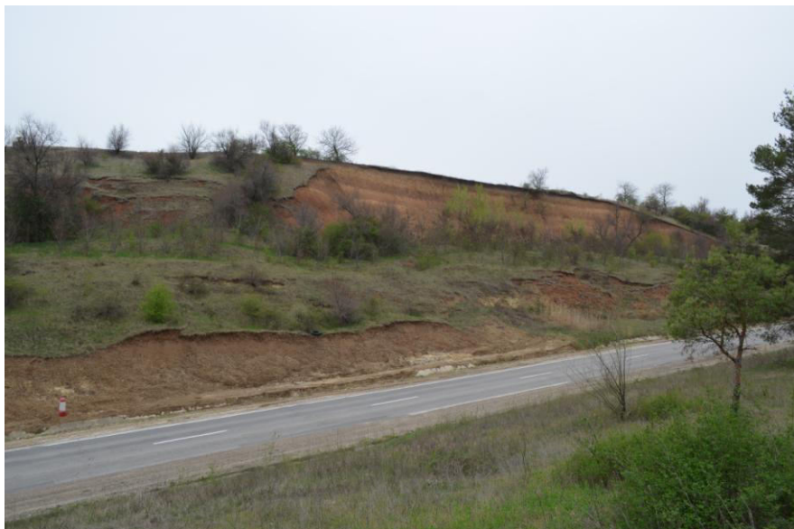
Рис. П.1 Участок автодороги Кишинэу-Полтава (автодорога М21), подверженный оползневым деформациям (фото: Кырлан А.)
