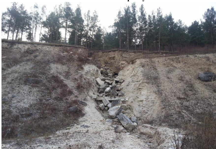
Рис. П.4. Деформация откоса на участке автодороги «Обход г. Рэзень» (фото: В.Калитина)
