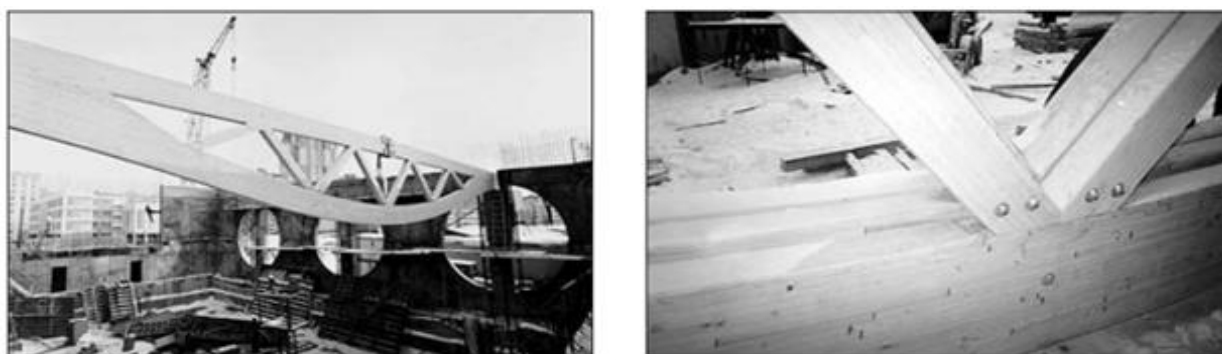
Рис. 4. 1)Монтаж линзообразной фермы. 2)Узел решётки линзообразной фермы.
