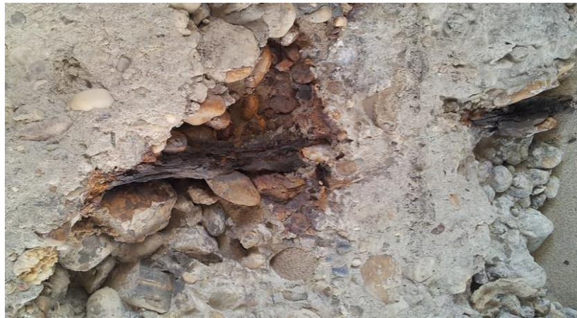
Рис.1. На скорость коррозии непосредственное влияние оказывает цемент, который использовался при строительстве.
