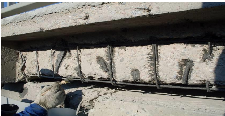
Рис.9. Металлические части конструкции покрывают специальными лакокрасочными защитными материалами.
