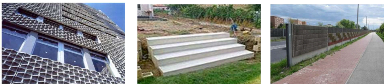
Figura 2. Elemente de fațadă, trepte prefabricate și panouri absorbante din beton armat cu fibre din polipropilenă [2]
