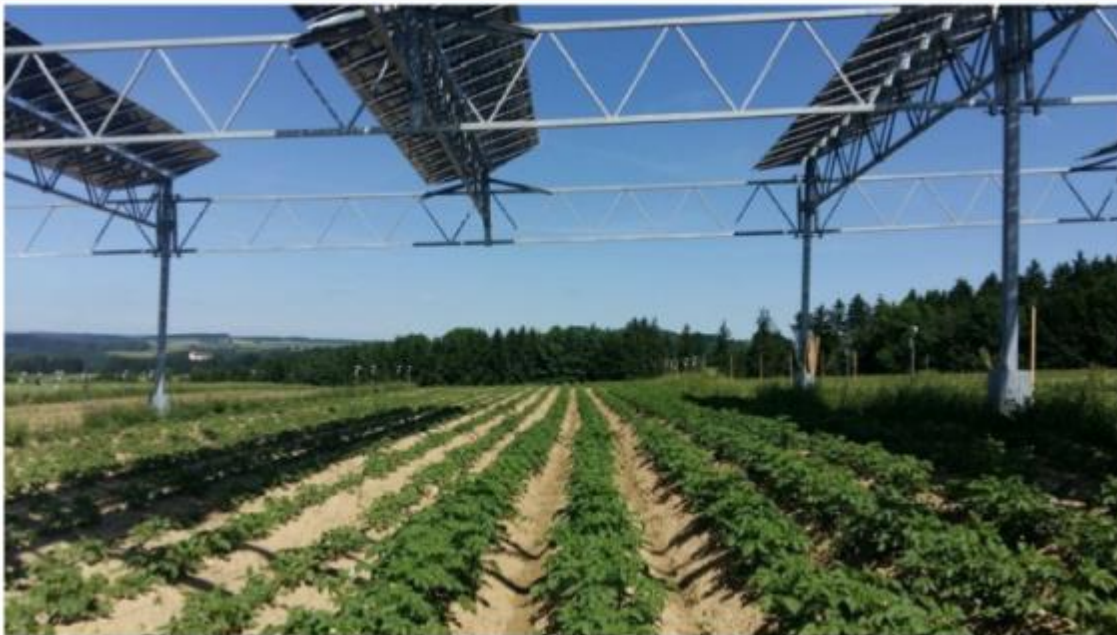
Fig. 1 Cultură de cartofi sub o instalație APV.
