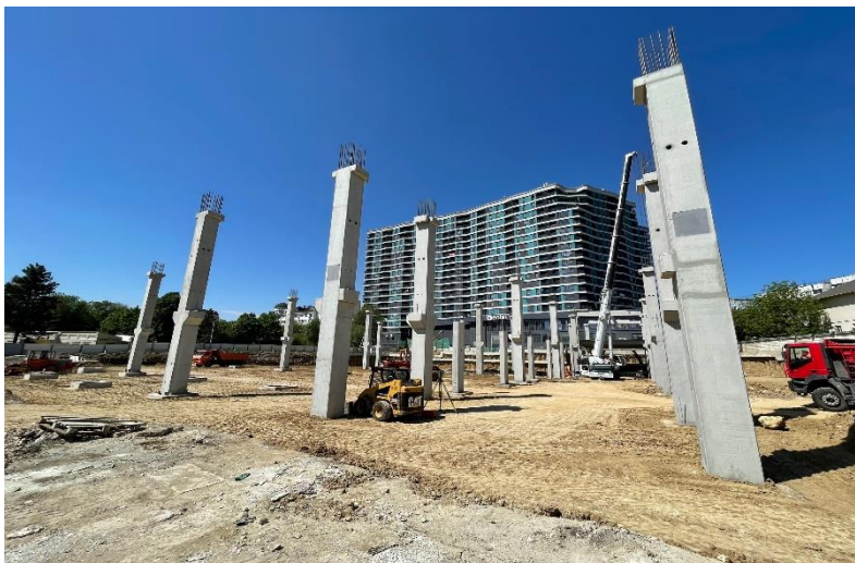
Figura 5. Construirea centrului comercial KAUF LAND din elemente prefabricate din beton armat or. Chișinău
