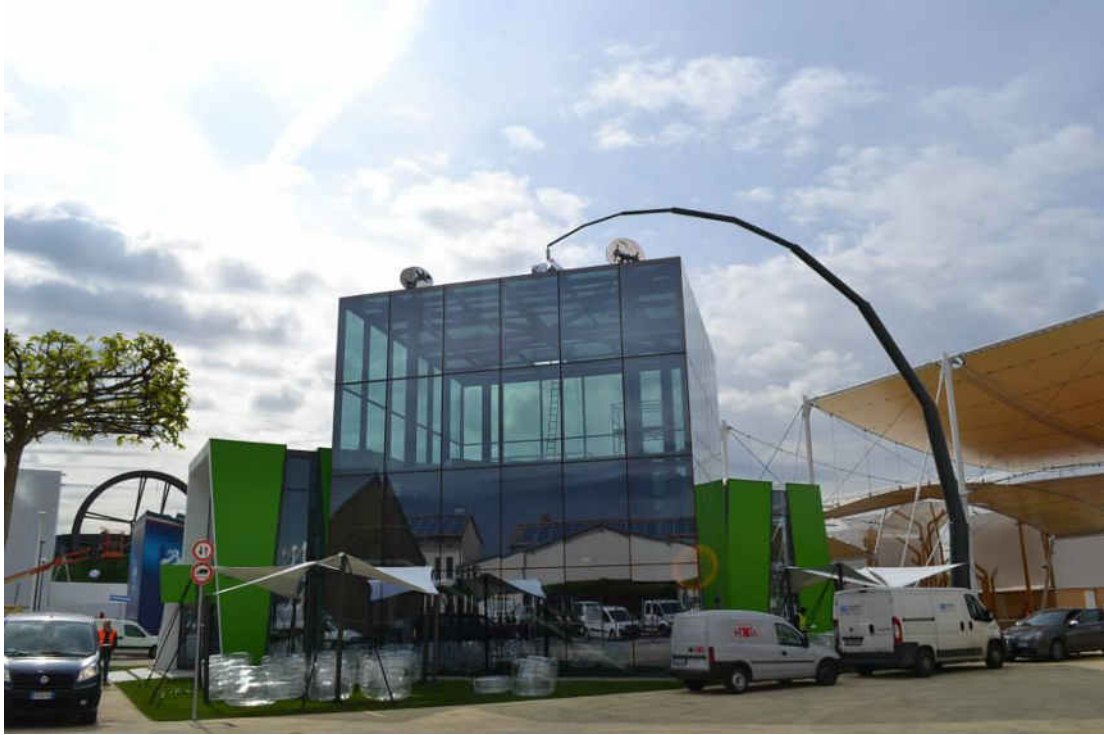
Fig. A3.4. Clădirea cu sistemul de reflecție a luminii instalat
