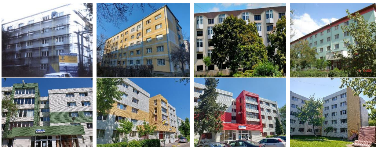
Figura 1. Blocul din Iași Strada Tabacului aflat în proprietatea autorităților locale și Cămine studențești reabilitate termic în campusul Tudor Vladimirescu al Universității Tehnice „Gh.Asachi” din Iași
