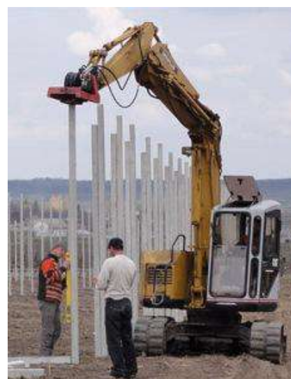
(b) Instalarea stâlpilor.
