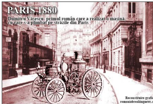
Fig.10. Reconstituire grafică realizată de romaniabreakingnews.ro cu automobilul construit de D.Văsescu după imaginea unui grafician francez care s-a inspirat după prototipul unei mașini cu motor cu abur conceput de Amedée Bollée (tatăl).
