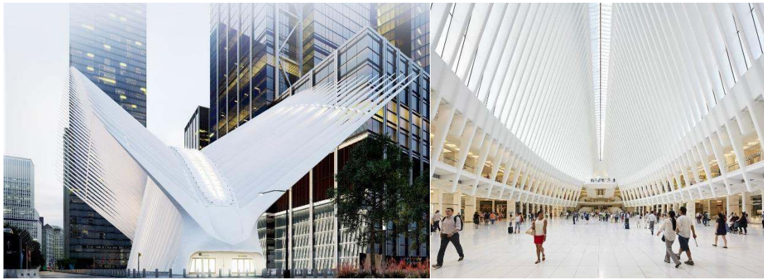
Figura 1: Imagini din exterior și interior, Oculus, World Trade Center, New York, autor Santiago Calatrava
