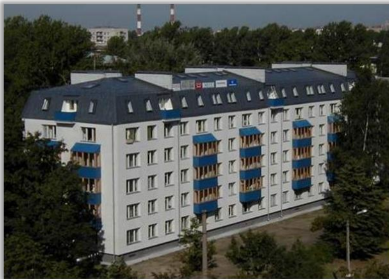
Figura 3. Reabilitarea unui bloc locativ cu construcția mansardei.
