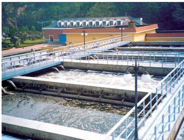
Fig.6. Vedere plan a procesului de spălare a sistemului BIOFOR Plus
